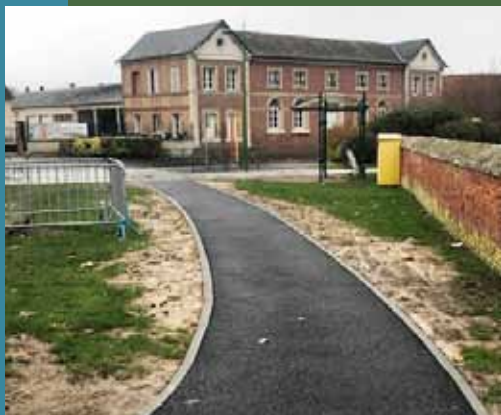
Réalisation d'un accès piétonnier sécurisé parking mairie
