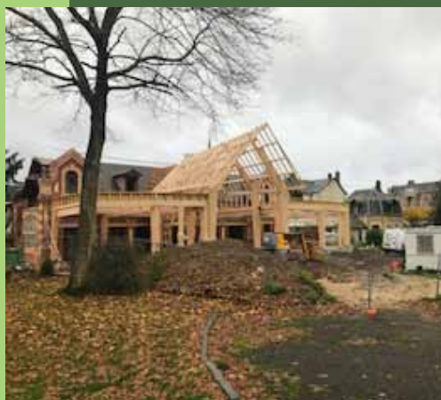
Avancement des travaux de la future médiathèque
