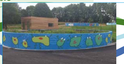
Bassin des grenouilles et local pédagogique
